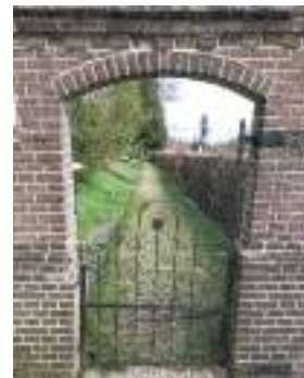
Rechts: Toegangs- poortje en pad direct naast het spoor
