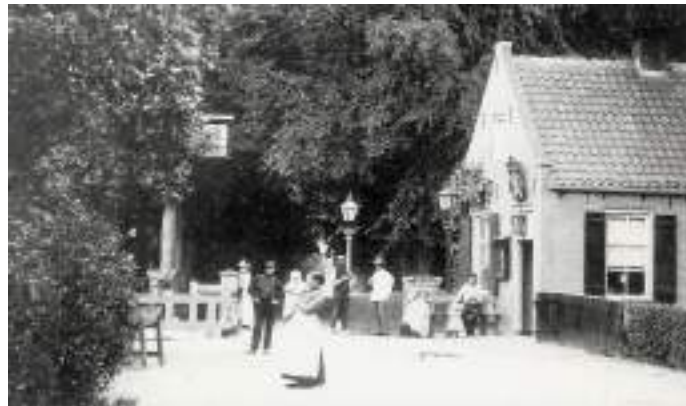
Figuur 2: Het voormalige tolhuis te Brummen met het rijkswapen aan de voorgevel (1894) 11
